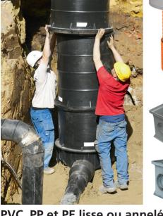
PVC, PP et PE lisse ou annelé et béton
